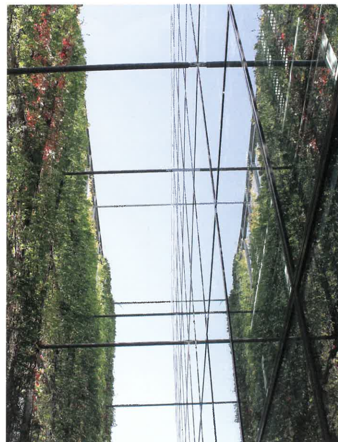
De tussenruimte tussen de glazen en de groene gevel van 4 meter levert heel wat voordelen op: de planten ontvangen voldoende licht aan de binnenkant en ventilatie tussen gebouw en wand zorgt voor extra verkoeling.
