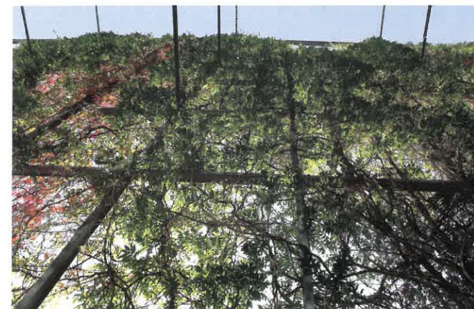
De zuidwest gerichte groene gevel dient als scherm voor het kantoorgebouw en vormt als het ware een extra gevel.
