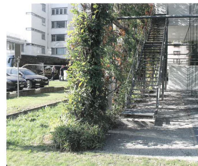
De tussenruimte tussen de glazen en de groene gevel van 4 meter levert heel wat voordelen op: de planten ontvangen voldoende licht aan de binnenkant en ventilatie tussen gebouw en wand zorgt voor extra verkoeling.
